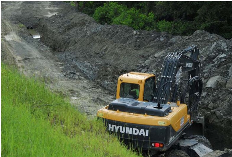
La obra del colector principal o CPI fue iniciada por Guanco y retomada en marzo por la UEB de Rehabilitación de Redes. Su objetivo: eliminar el vertimiento directo de residuales en la corriente del río Guaso.
