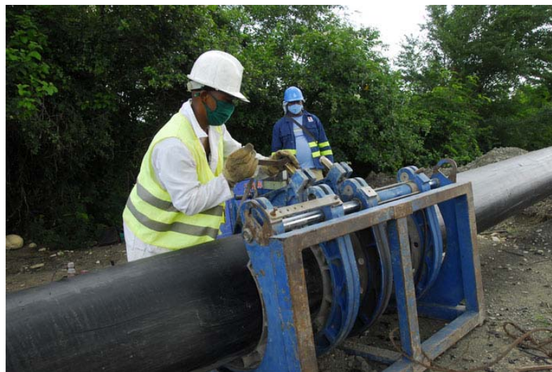
Mientras se abre la zanja, en una estación cercana en el vial de acceso de Laja Peral, se preparan en la máquina de termofusión los "pepinos", integrados por ocho tramos de 12 metros cada uno.
