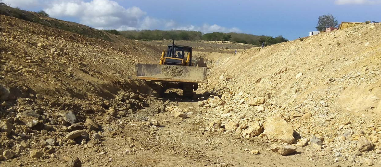
A punto de concluirse estaba hace unos días la conformación de la calicata de entrada al primer túnel. Las calicatas son excavaciones de profundidad pequeña a media, realizadas normalmente con pala retroexcavadora, según Wikipedia.
