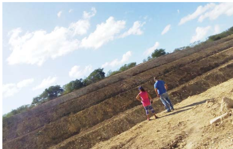
Desde una vista superior el proyectista principal de la obra, Aniel Álvarez, y la ingeniera Dalaiti James Morales, jefa de área técnica ejecutiva de la UEB Trasvases, comprueban el trabajo de terminación de la calicata de entrada al primer túnel.
