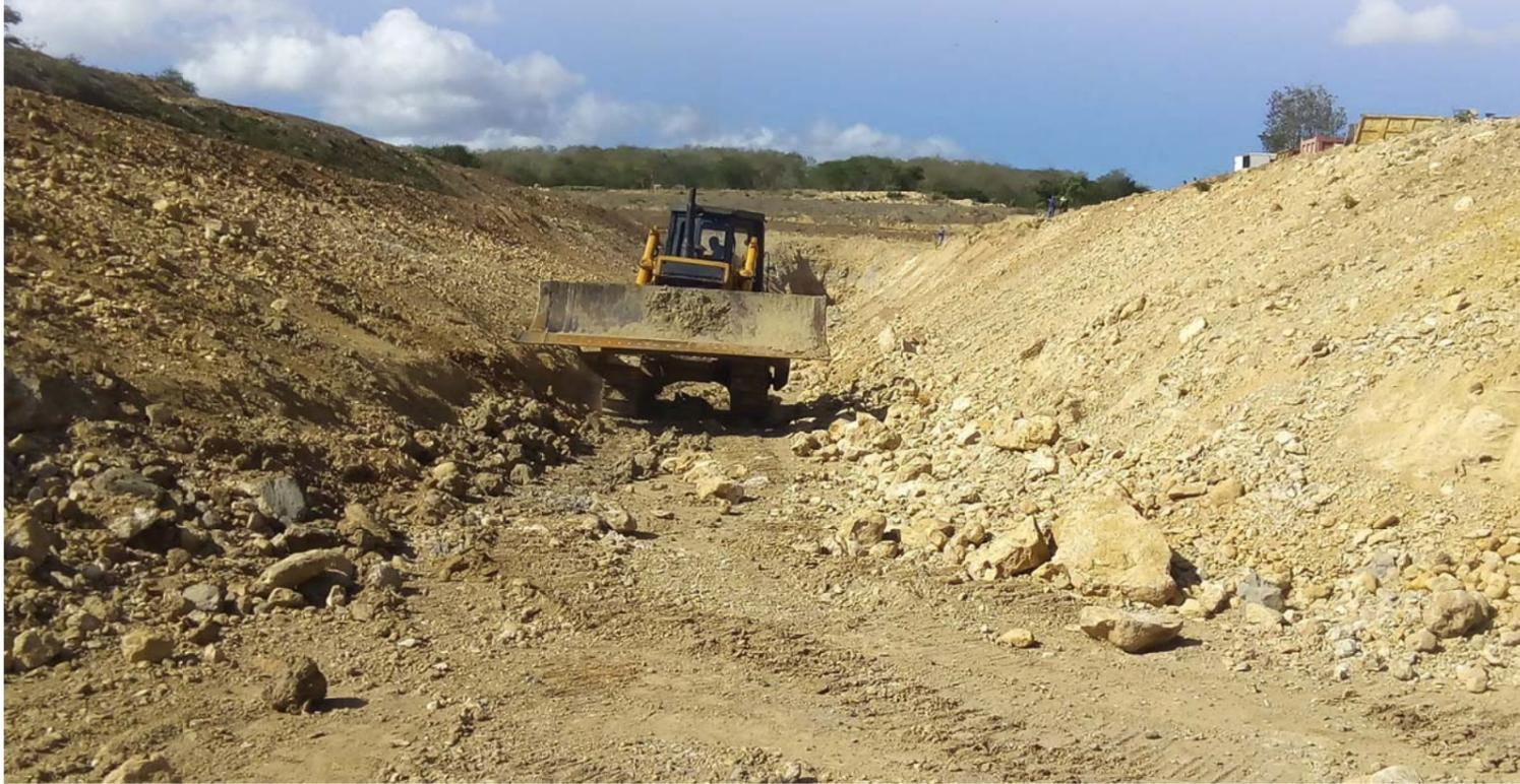
A punto de concluirse, se conformaba la calicata de entrada al primer túnel. Las calicatas son excavaciones de profundidad pequeña a media, realizadas normalmente con pala retroexcavadora, según Wikipedia.
