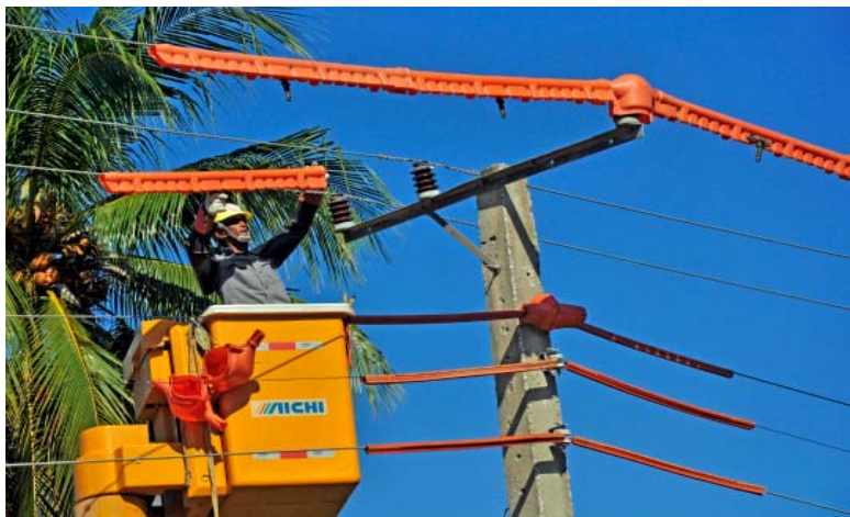
El trabajo "en caliente" de las líneas permitió afectar menos a la población.
