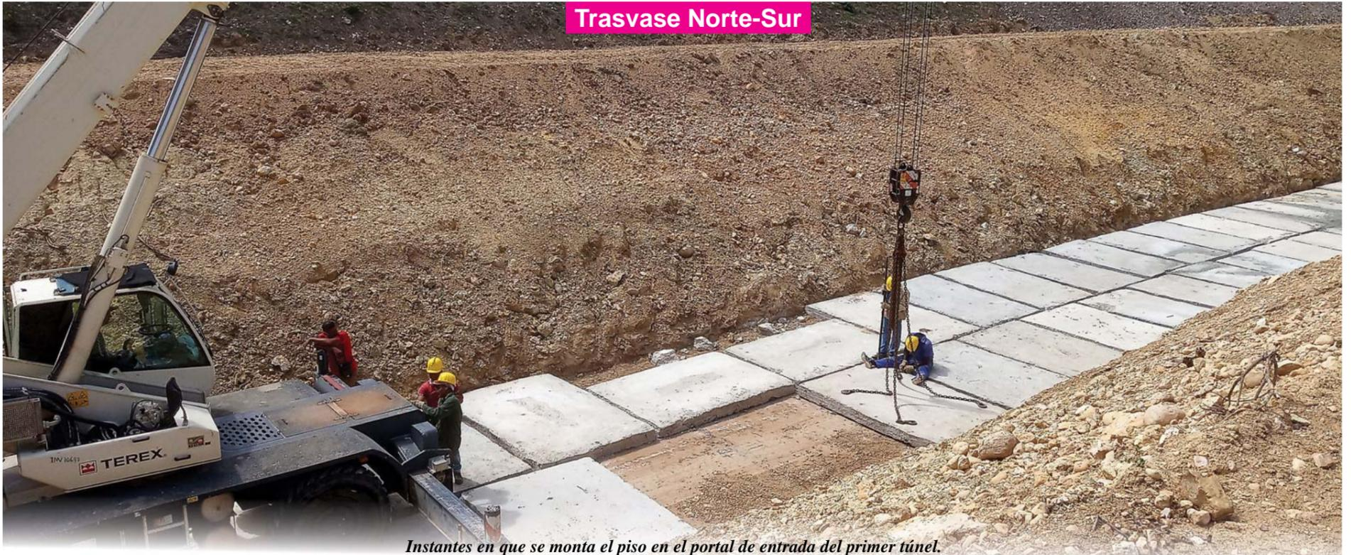
Instantes en que se monta el piso en el portal de entrada del primer túnel.
