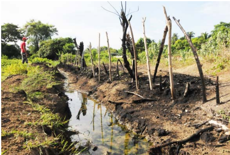
Esta zanja donde hay residuos de hidrocarburos afecta las áreas de cultivo y está muy próxima a un camino real. Sin protección alguna, como se aprecia, está a merced de otro incendio.
