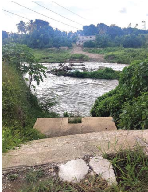
Imagen actual de la obra. Al centro, la ataguía que permite la fundición en seco de los cimientos, con cemento de altas prestaciones.
