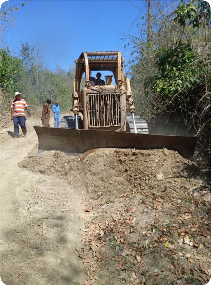
Desbrozar, ampliar el vial y rellenar socavamientos constituyen tareas de Alexander Sosa y su buldócer.
