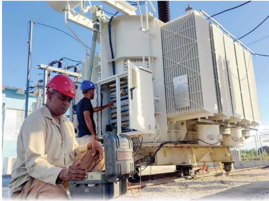
*Después de varias pruebas, incluida la del aislamiento eléctrico, no ha podido determinarse el origen de la avería, asegura Ferrer Soublet, en primer plano.*
