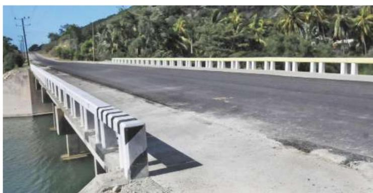
*El puente de la carretera central en la localidad de Yacabo Abajo muestra nueva imagen, luego de la reconstrucción de los estribos, los cuales fueron completamente destruidos por el meteoro.*
