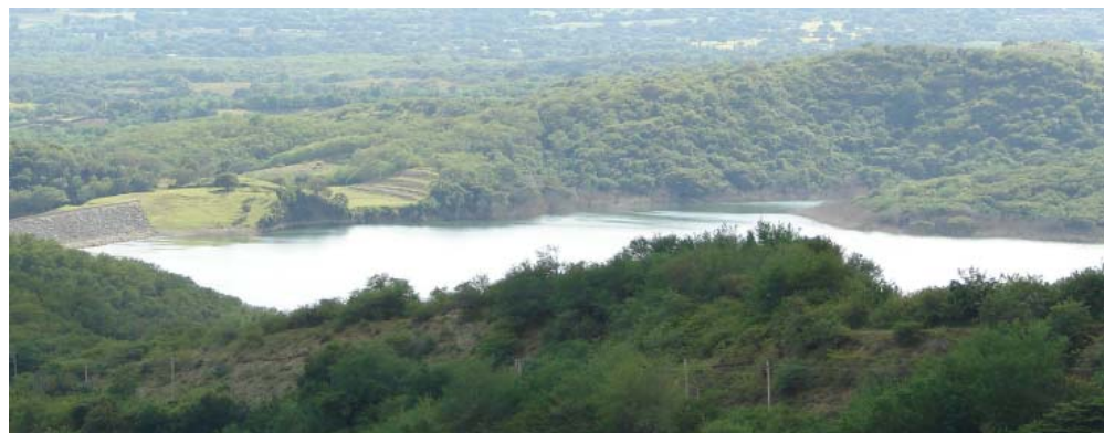
La presa Pozo Azul, con capacidad para 14,6 millones de metros cúbicos, recibe y entrega el agua por gravedad al Valle de Caujerí.
