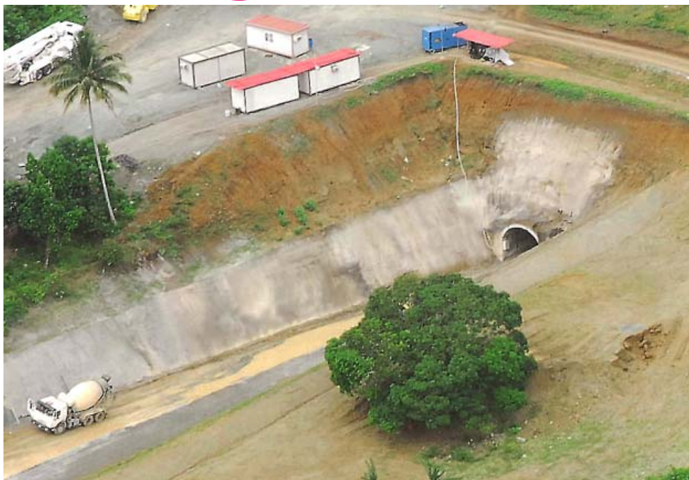
Vista aérea de uno de los dos túneles del trasvase Sabanalamar-Pozo Azul, obra que funde utilidad y belleza.
