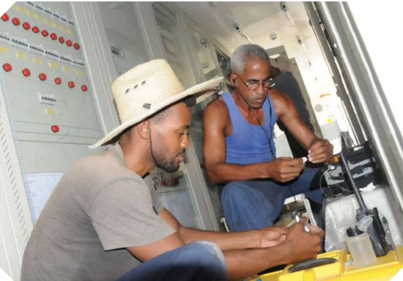
Desde el centro de control se termina el empalme de la fibra óptica.
