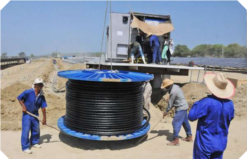
Avanza el soterrado de la fibra óptica.
