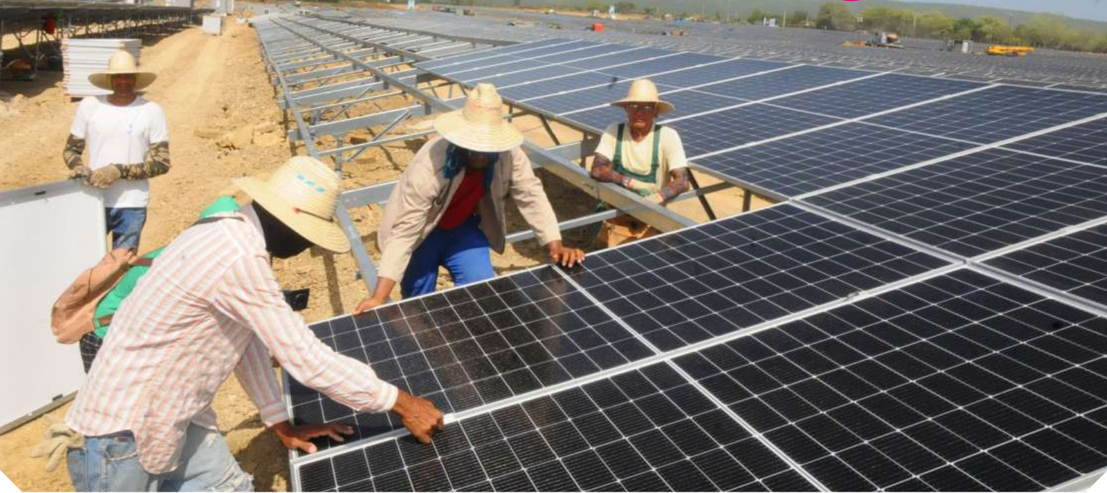
El parque está a más del 90 de ejecución y se prevé que cinco, de las siete explanadas, sincronicen con el SEN a finales de agosto.
