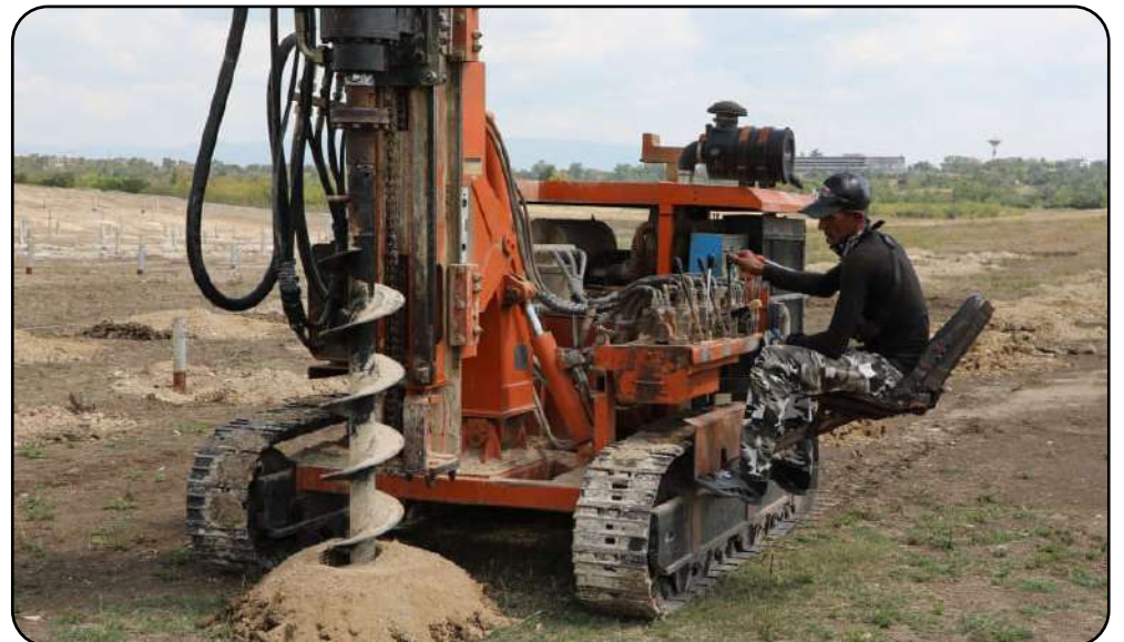
La perforación para pilarotes, con una brigada de Cubiza, es de las principales actividades en el parque San Pedro 2, uno de los dos primeros que aportarán energía acumulada en bancos de baterías en Guantánamo.
