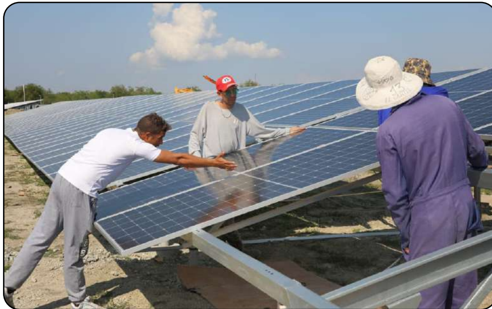
Los parques de 21.8 MW como El Algarrobo, donde hoy se apura el montaje de paneles, se estima que aporten una generación anual de 35 mil megawatt/h.
