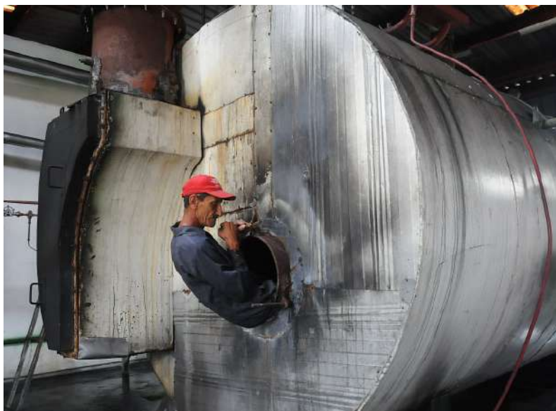
Trabajadores de Alastor laboraban en la corrección de la avería de la caldera.
