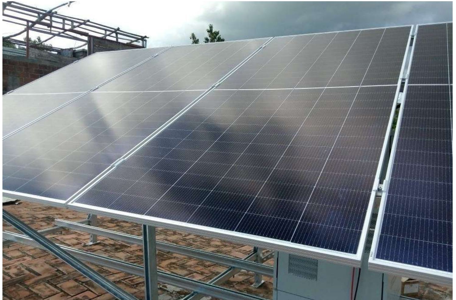
Instalación de paneles solares en la Casa de Abuelos.
