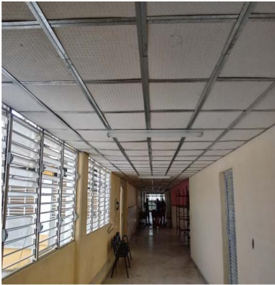
En instalaciones del territorio como el Hospital Doctor Agostinho Neto (izquierda), el falso techo es de losas de fibra de coco y yeso producidas y montadas por Industrias Locales de Guantánamo (derecha), solución enfocada a sustituir importaciones.
